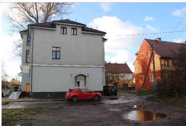
Фотография 3.2. Внешнее состояние объекта
