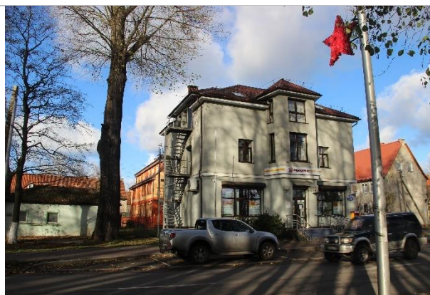
Фотография 3.1. Внешнее состояние объекта
